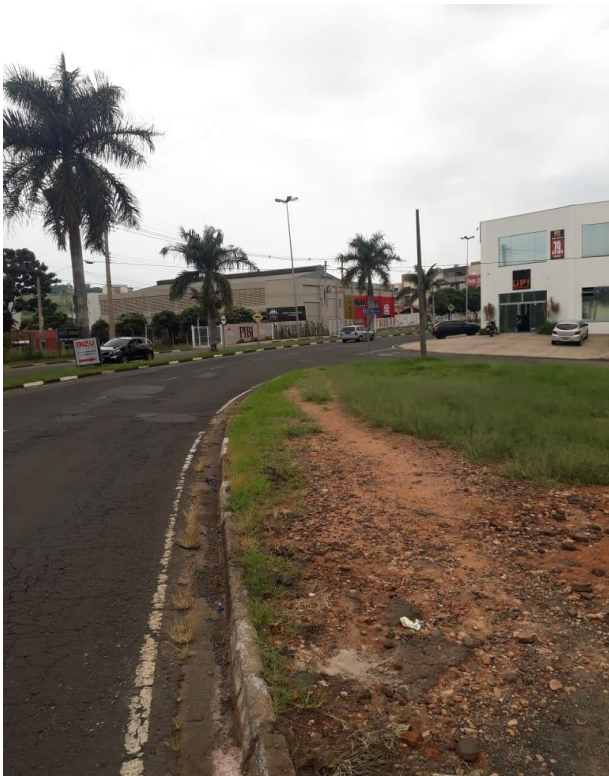
Foto 03: Av. Antônio Pinto Catão
