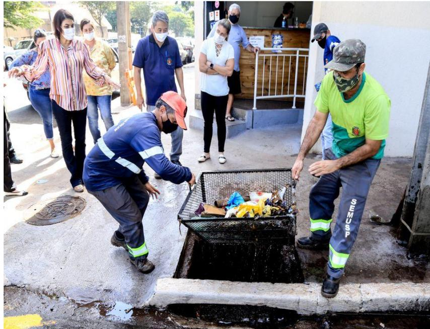
Este aparelho instalado tem como finalidade de combater o entupimento dos bueiros e a preservação do meio ambiente, impedindo que a quantidade de sujeira e lixo descartado irregularmente nas ruas cheguem aos rios e aos encanamentos.
