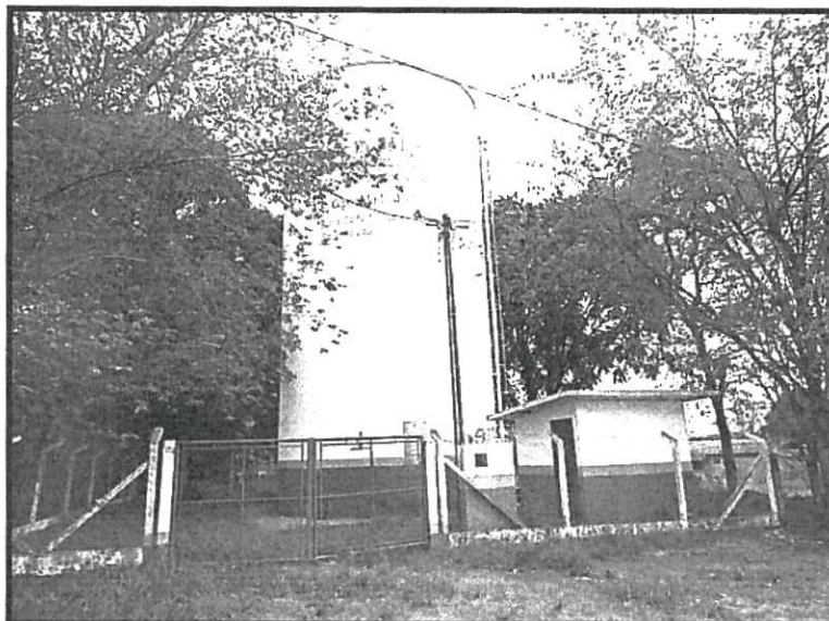
Figura 51 - Reservatório Santo Antônio do Jardim (400 m 3 ).
