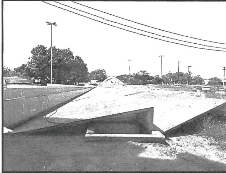
Figura 27 - Reservatório Semi-enterrado R1 - ETA Central.
