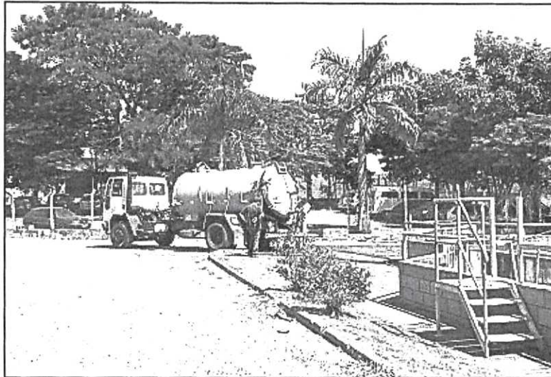
Figura 57 - Caminhão fossa despejando esgoto na EEEB Central.
