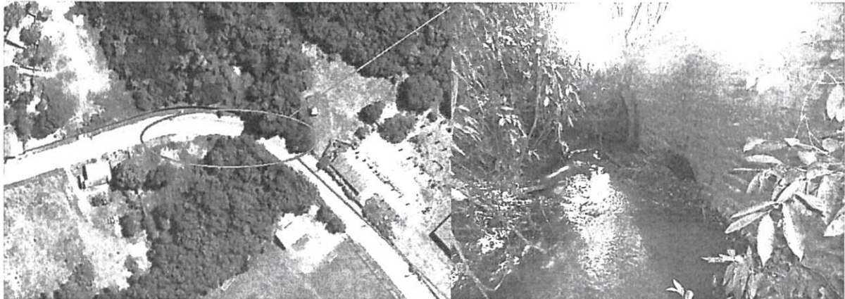
Figura 124 - Travessia de corpo hídrico na Av. Pacífico Moneda.
