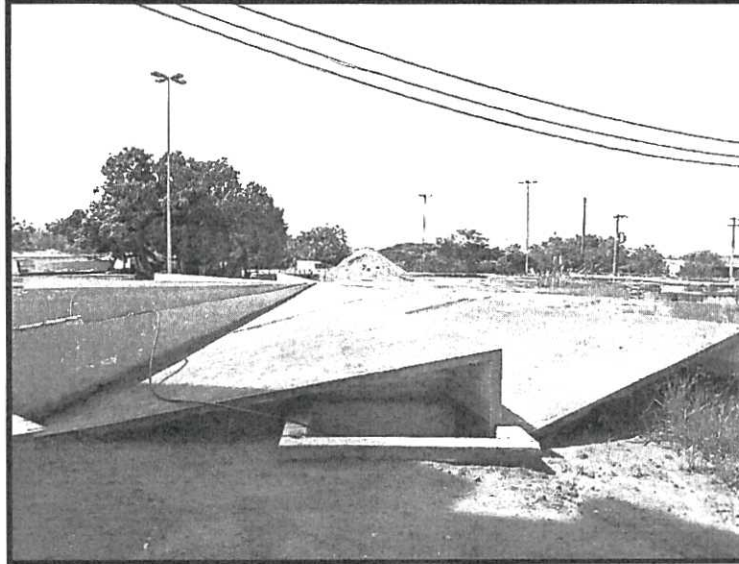
Figura 27 - Reservatório Semi-enterrado R1 - ETA Central.
