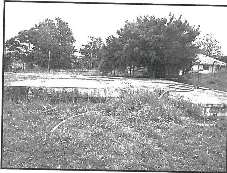
Figura 49 - Reservatório Enterrado ETA Ana Helena (200 m 3 ).
