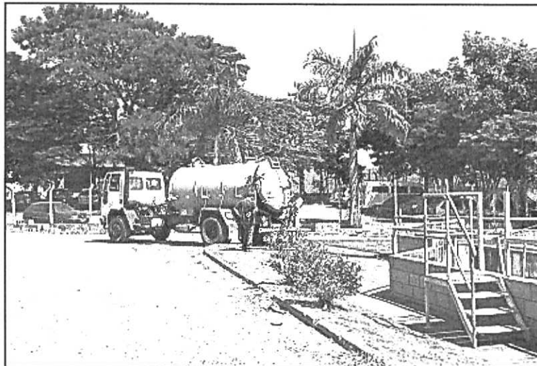
Figura 57 - Caminhão fossa despejando esgoto na EEEB Central.
