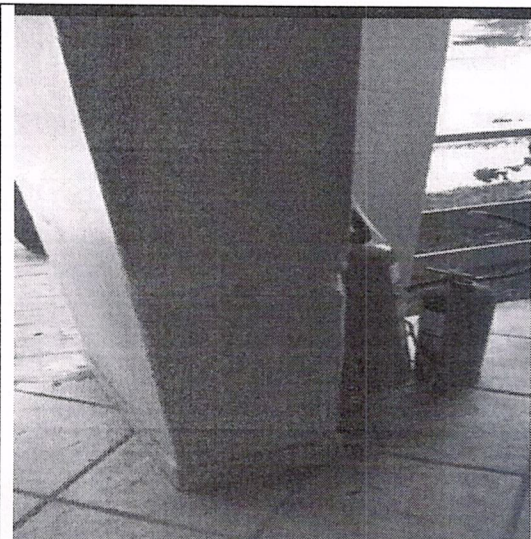
Pintura descascada
